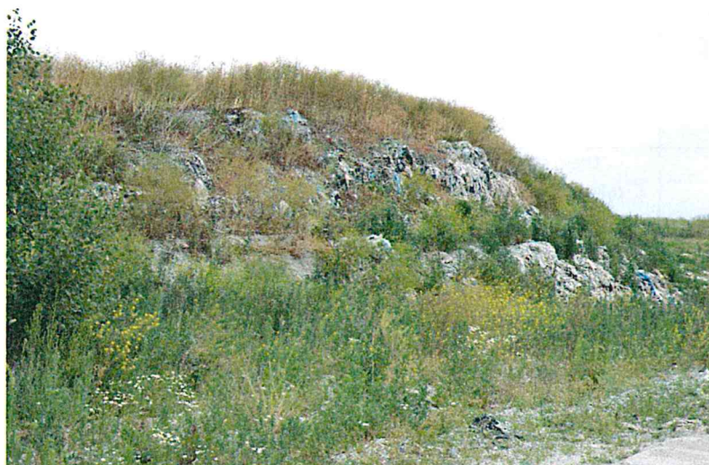
Fot. 1. Stara część składowiska odpadów w Czartorii – stan przed rekultywacją
