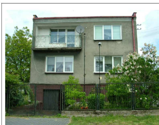
a) Widok na punkt pomiarowy P09
